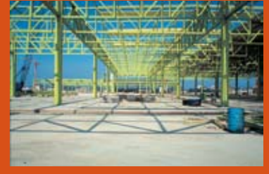
Das Daimler-Werk in der Bauphase
