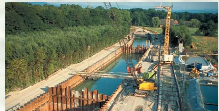
Die Baustelle während des Tunnelbaus...
