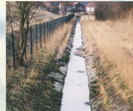
Befestigter Graben im Rastatter Bruch
